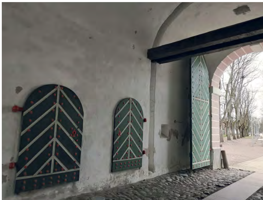
Pärnu Tallinna värava väravakäigu välimise osa kaitseelemente: langevõre, laskeava, puust väravad, avaus laes
