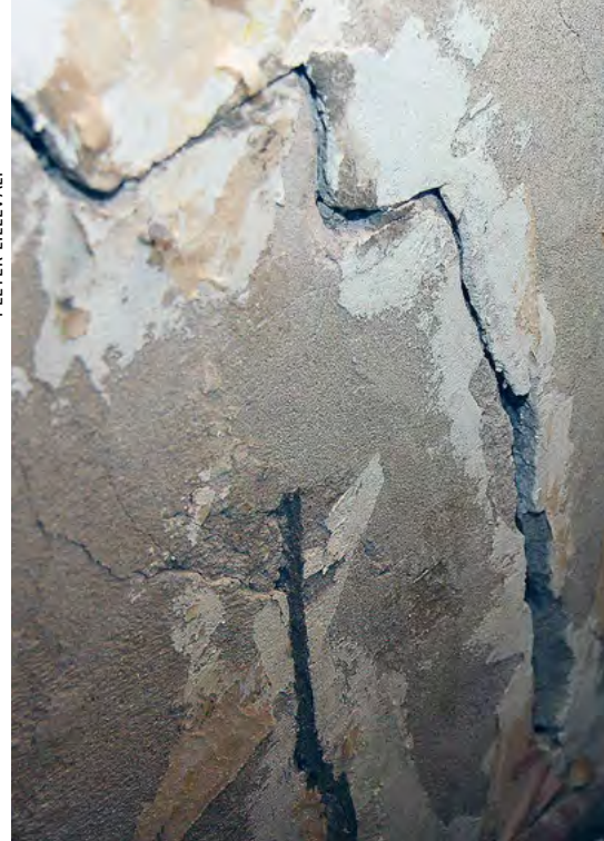
Põlevkivikaevanduste tõttu vajub maapind Eestiski. Pildil on Kohtla-Järvel Sinivoore tänaval altkäevandatud alal vajumise tõttu katki pragunenud kortermaja sein
