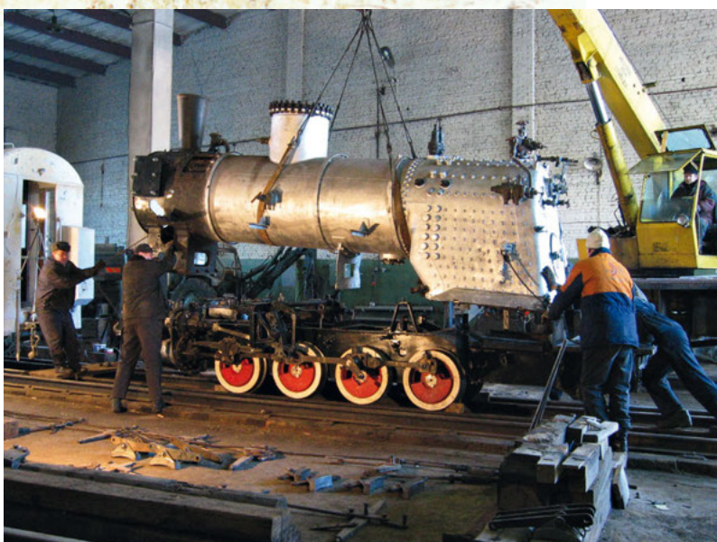
Veduri remont Lätis Gulbenes 2005. aastal
