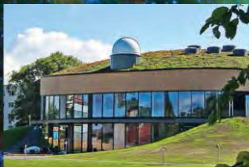
Observatorium Pärnumaa Keskonnahariduskeskuse katusel
