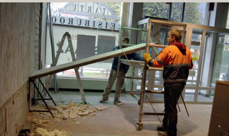
Konserveeritud pannoo seinalt eemaldamine.
