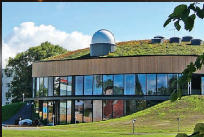
Observatoorium uue Pärnumaa Keskkonnahariduskeskuse katusel
