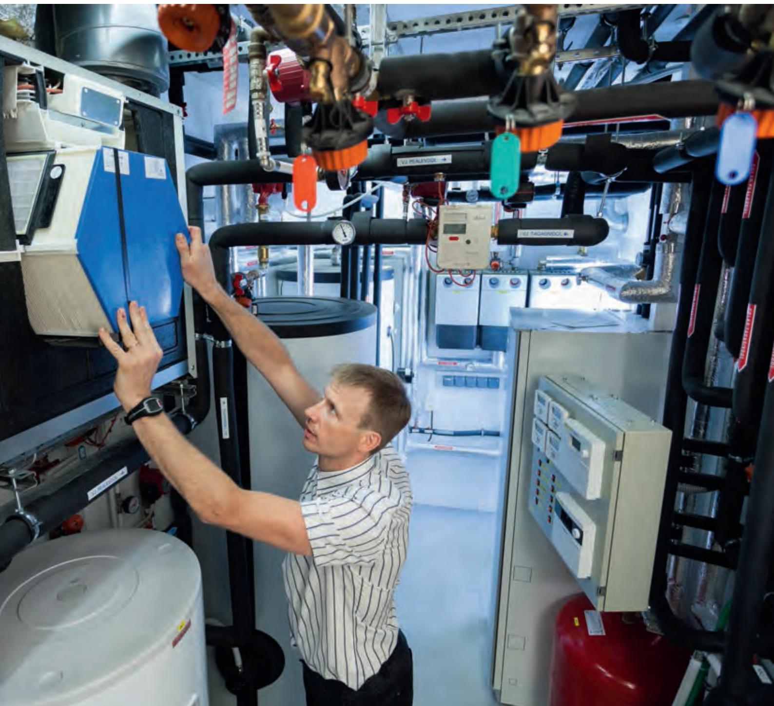
Professor Targo Kalamees näitab unikaalse liginullenergiahoone testmaja tehnoruumi, mis oleks nagu otsast otsani täis omavahel läbi põimunud küttesüsteemide torusid. Sinine kuusnurk on plaatsoojusvaheti.
